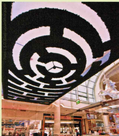
Im Toscana-Café absorbiert ein Deckenlabyrinth aus Mooselementen den Schall (Konzept: L.S.D. Lintschinger & Stieglmayr Design GmbH, Fischlham/Österreich).
